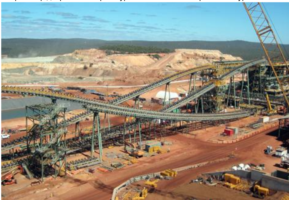
Ньюмонтын алтны уурхайн конвейерийн байгууламж
